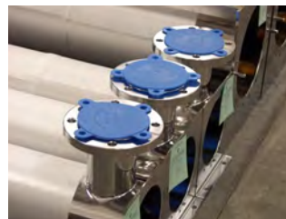
Soldaduras de tubos sobre bridas.
