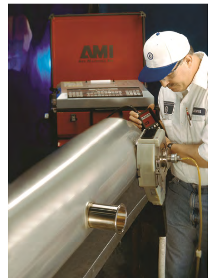
Posicionamiento del cabezal sobre tubo en "T"
